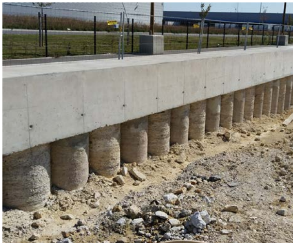
Figure 21 : Exemple de paroi en pieux sécants avec poutre de couronnement
