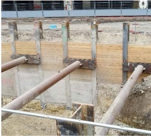
Figure 20 : Exemple de paroi berlinoise
