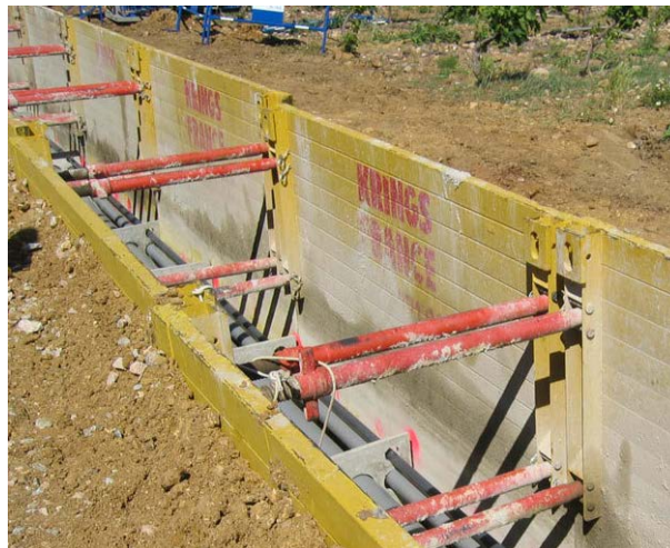
Figure 19 : Exemple de caissons métalliques (source image Krings)
