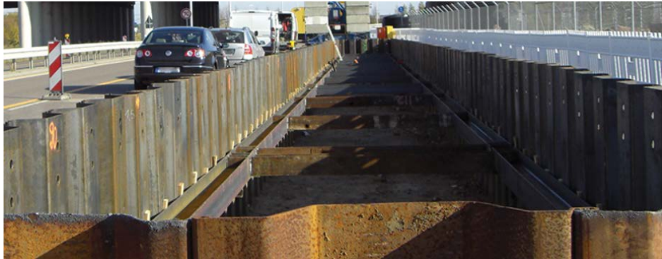
Figure 22 : Exemple de tranchée soutenue par palplanches (image Arcelor Mittal)
